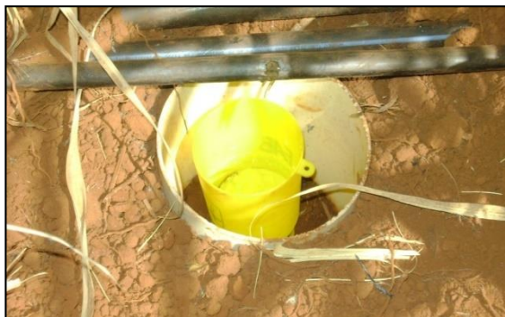
Figura 9. Foto do dispositivo para monitoramento de vazão nos tubos gotejadores.
