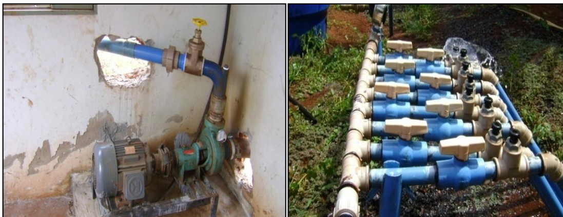
Figura 8. Fotos do conjunto motobomba e do cabeçal de controle do sistema de irrigação.
